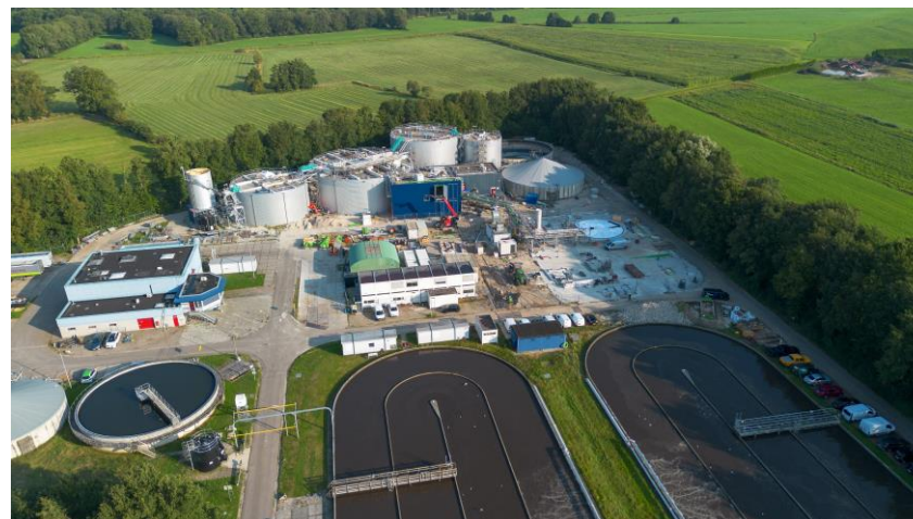
Figuur 5: Groengasinstallatie rwzi Echten
