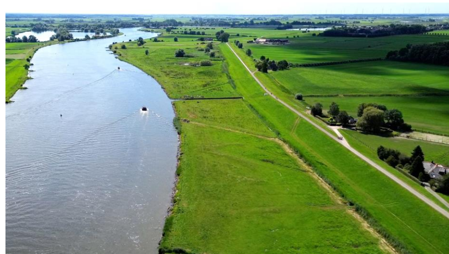
Figuur 7: Dijk Mastenbroek-IJssel (ter hoogte van 's Heerenbroek)
